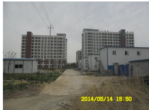
项目北侧临时施工场地（即将拆除）
