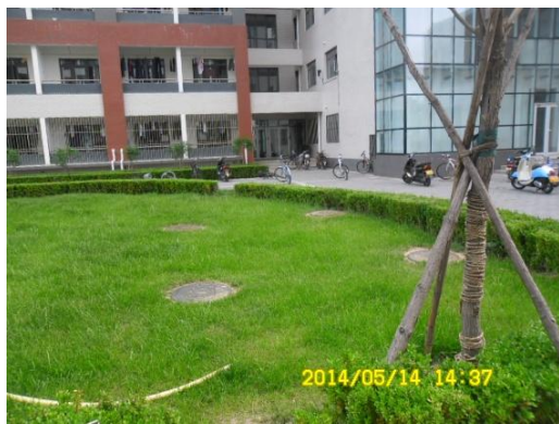
丹枫园 A 楼化粪池
