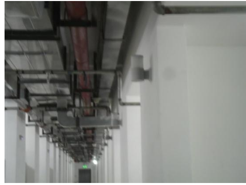
地下通风管道
