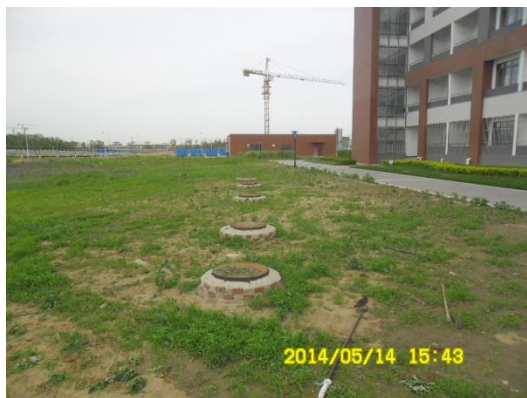
丹枫园 C 楼化粪池
